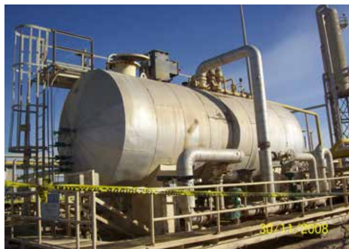
Powłoka z materiału Belzona 5892 zastosowana na odsalaczu
