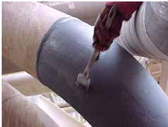
Materiał Belzona 5851 zastosowany w celu zabezpieczenia rur przed korozją
