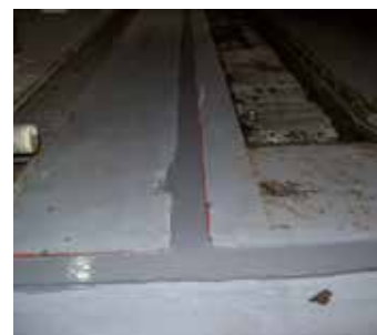
Naprawiono przy użyciu materiału Belzona 4521
