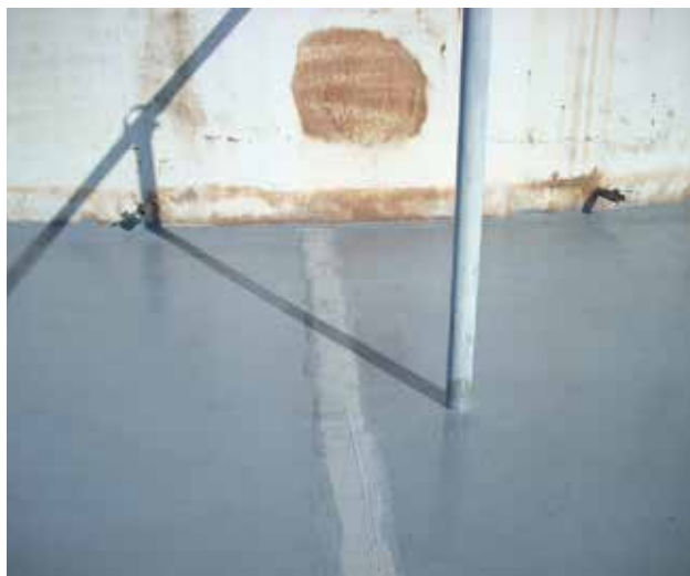
Zastosowanie do odbudowania uszkodzonych szczelin w strefie bezpiecznego przechowywania substancji chemicznych
