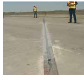
Naprawiona szczelina
