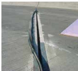
Uszkodzona szczelina
