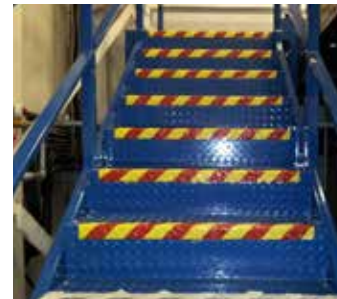
Schody metalowe po aplikacji
