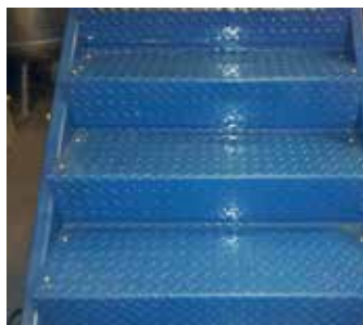
Schody metalowe przed aplikacją
