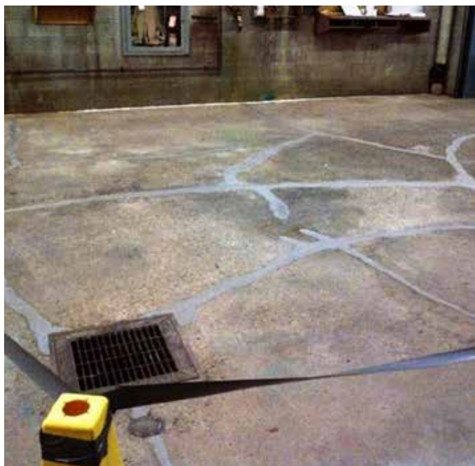
Pęknięcia naprawione przy użyciu systemu Belzona 4151 oraz 4111
