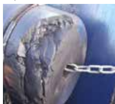
Odbudowa uszkodzonej części
