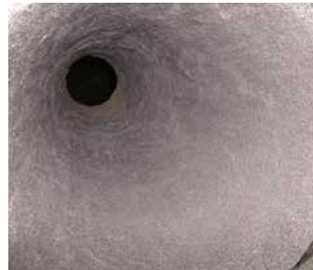
Lej stalowy pokryty powłoką Belzona 1812
