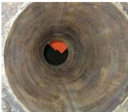
Lej stalowy przed nałożeniem powłoki
