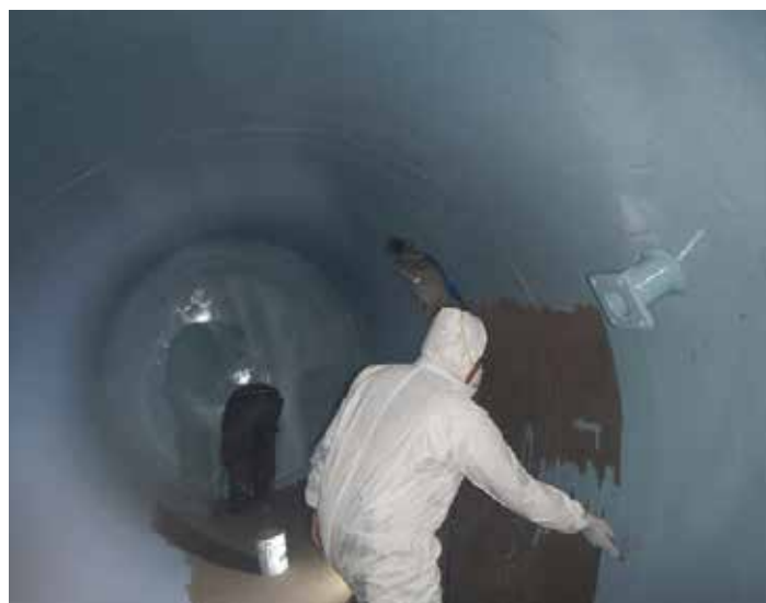
Ręczne zastosowanie powłoki Belzona 1391T
