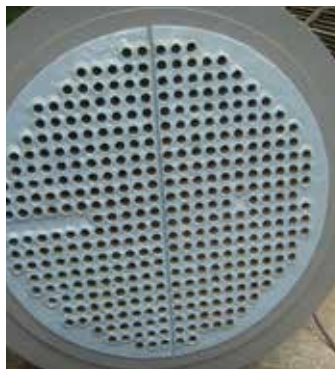
Zabezpieczenie wymiennika ciepła
