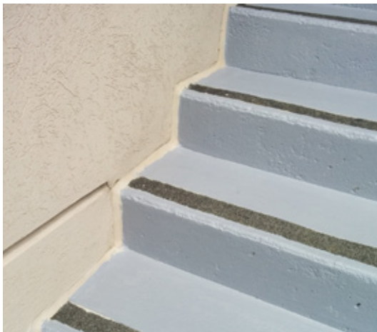
Schody do odbudowane i zabezpieczone antypoślizgowo kompozytem Belzona 5231
