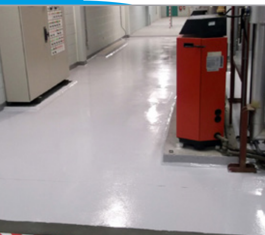
Posadzka po nałożeniu powłoki antypoślizgowej Belzona 5231
