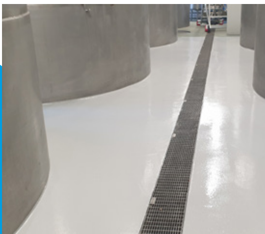
Nałożenie powłoki antypoślizgowej Belzona 5231
