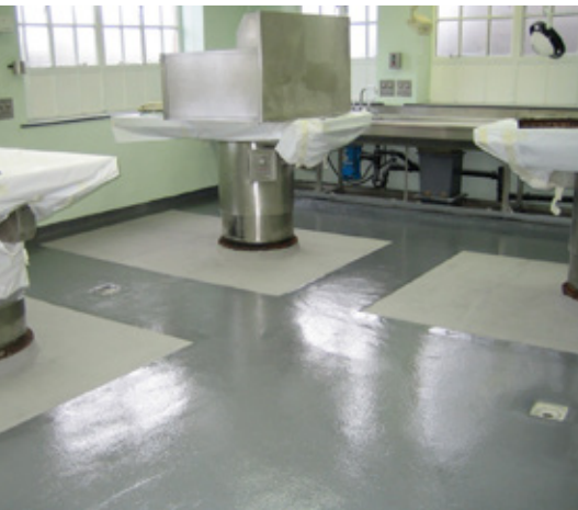
Podłoga odbudowana i zabezpieczona z użyciem Belzona 5231
