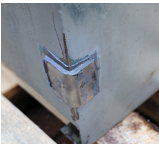
Belzona 1212 - naprawa wanny olejowej
