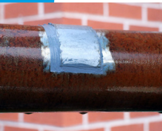
Naprawa uszkodzenia korozyjnego rury, na której osadza się kondensat
