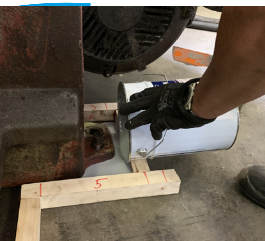
Wykonywanie podlewki pod ramą tokarki
