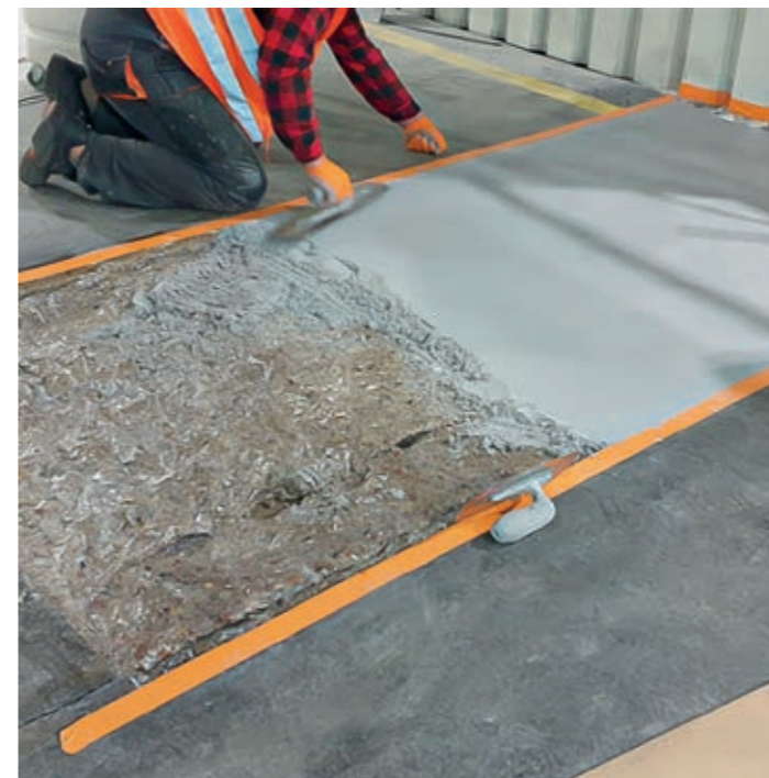
Fot. 6. Wykonanie kompozytem Belzona4111 połączenia podłóg z uskokiem pomiędzy dwoma halami
