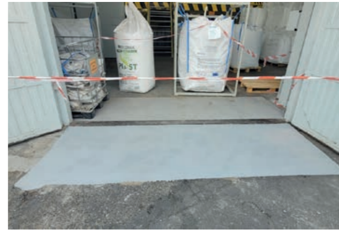
Fot.4d. Zmodernizowana kompozytem Belzona®4111 podłoga wraz z strefą zewnętrzną bramy wjazdowej do hali produkcyjnej.
