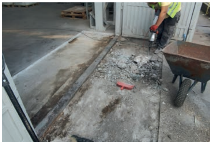
Fot.4b. Modernizacja podłogi w obrębie bramy wjazdowej do hali przemysłowej
