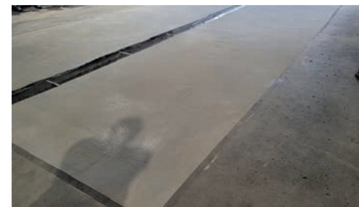
Fot.8d. Zabezpieczona taca rozładunkowa system kompozytowym systemem wzmocnienia i wieloletniej ochrony powłokowej
