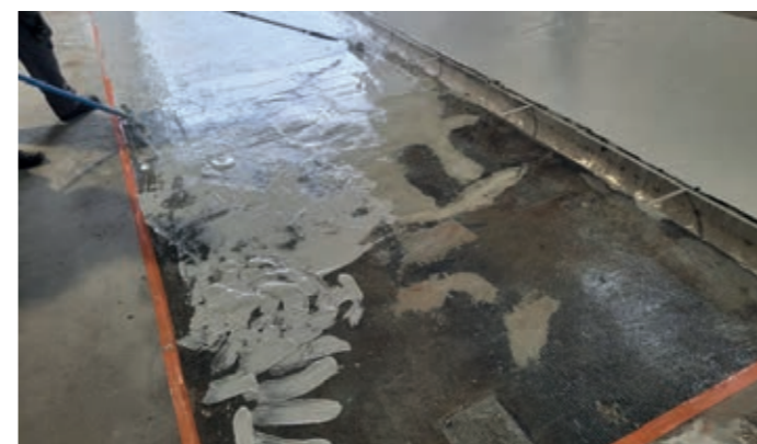
Fot.8c. Zabezpieczenie powierzchni tacy rozładunkowej powłką chemoodporną Belzona4111
