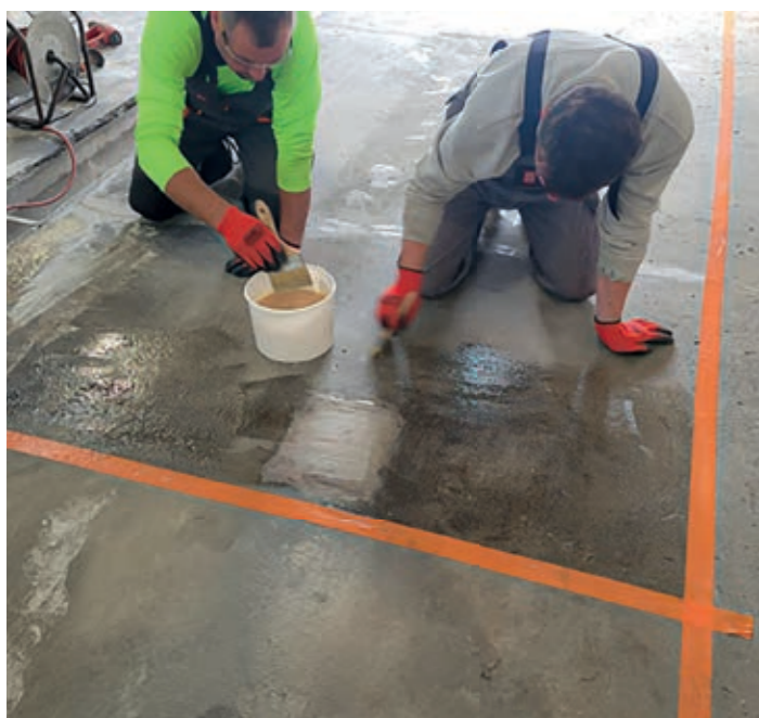
Fot.8b. Wzmacnianie warstwy betonu żywicą Belzona®4151
