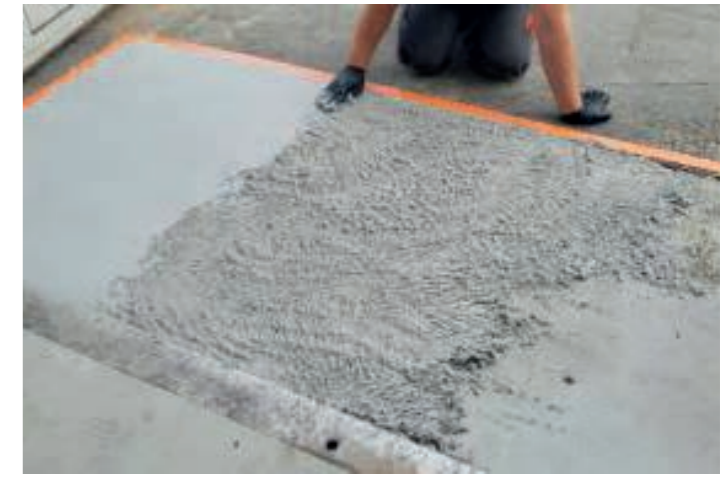
fot. 5. Skuteczne zabezpieczenie progów przejazdowych - brak uskoków i ciągłość odształceń wg stali, betonu i asfaltu
