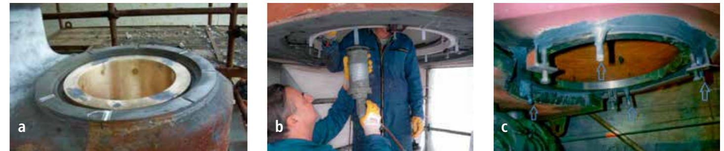
Fot.6. Osadzenie tulei łożyskowej steru, a) dla czopa steru – faza pozycjonowania, b) dla czopa trzonu – faza wtrysku ciśnieniowego, c) dla czopa trzonu – faza tuż po zakończeniu wtrysku wypełniającego kompozytem Belzona®1321 . Widoczne śruby ustalające i rozpięte struny pozycjonowania tulei do osi trzonu i czopa (jeśli jest, to również z osi wału)
