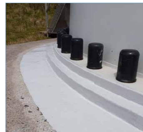
Fot. 4. Belzona®3412 - wykonanie szczelnej membrany zakotwień i posadowienia wieży turbiny wiatrowej
