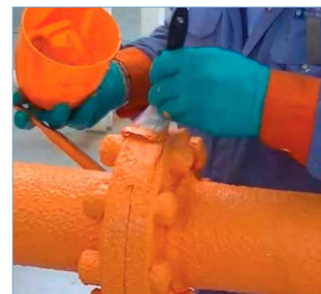
Fot. 7. Belzona®3412 w trakcie aplikacji pędzlem
