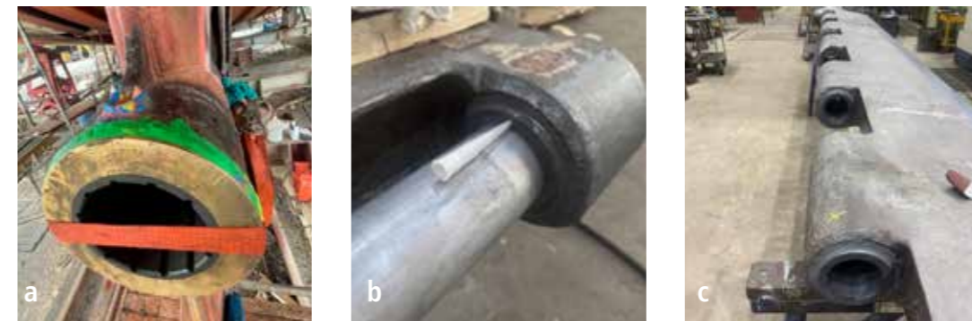
Fot.7. Przykłady zastosowania technologii osadzania tulei ślizgowych na kompozycie polimerowym w a) podporze wału głównego (tuleja metalowo/gumowa smarowana wodą) na Belzona®1111 , b) i c) osadzenie w jednej osi szeregu tulejek ślizgowych skrzydła steru na kompozycie Belzona®1321
