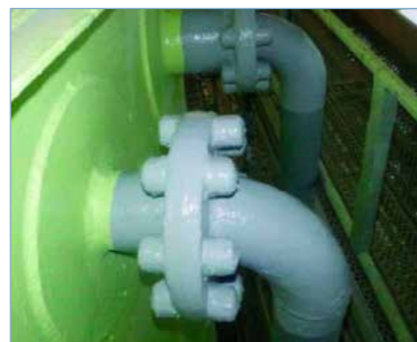
Fot. 2. Zabezpieczenie połączeń kołnierzowych zbiornika na chemikalia membraną Belzona®3412
