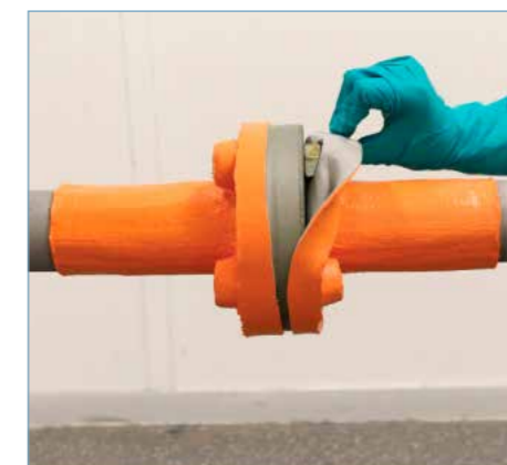
Fot. 8 a) Membrana Belzona®3412 tuż po nacięciu obwodowym
