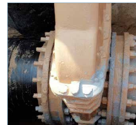
Fot. 5. Belzona®3412 jako szczelna i barierowa powłoka ochronna zasady podziemnej (wody gruntowe zasolone)
