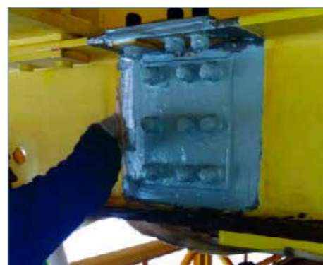
Fot. 3. Belzona®3412 - ochrona połączeń śrubowych konstrukcji mostu
