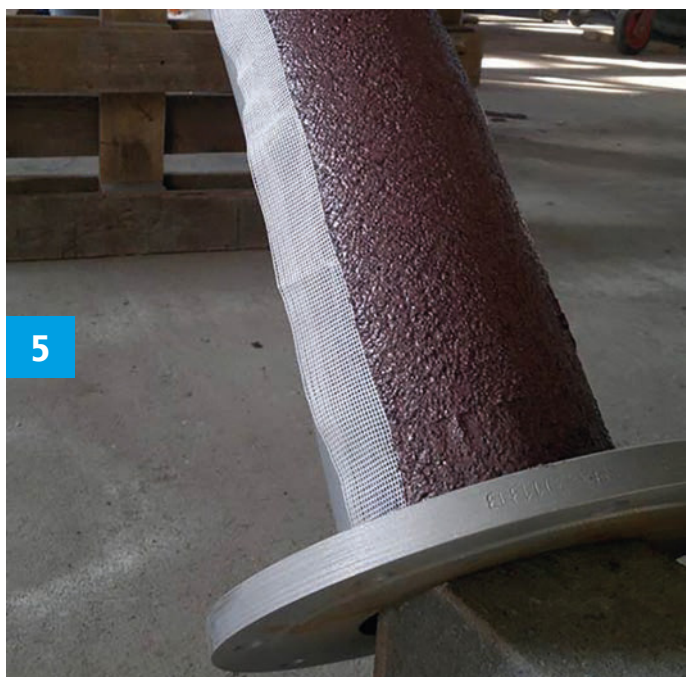
Fot. 5. Zabezpieczenie zewnętrznej krzywizny kolana pytoprzewodu kompozytem Belzona 1812.
