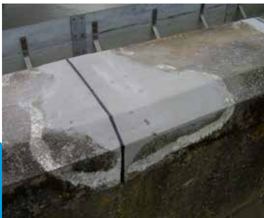
Belzona® 4511- Wypełnienie dylatacji korony osadnika betonowego
