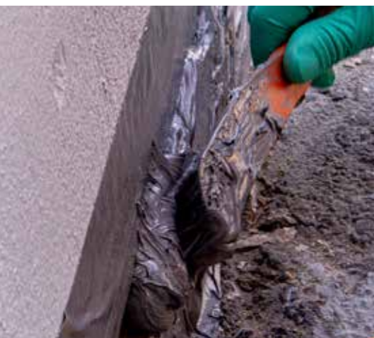
Aplikacja kompozytu Belzona® 4511
