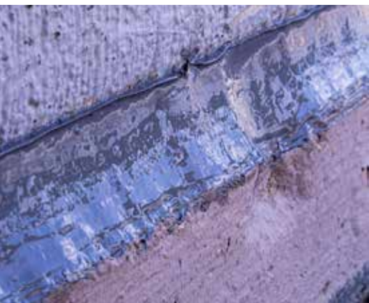
Elastyczne wypełnienie współpracujących elementów betonowych
