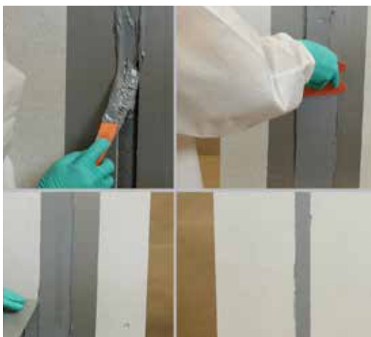
Aplikacja kompozytu Belzona® 4511 na dylatacje pionowe
