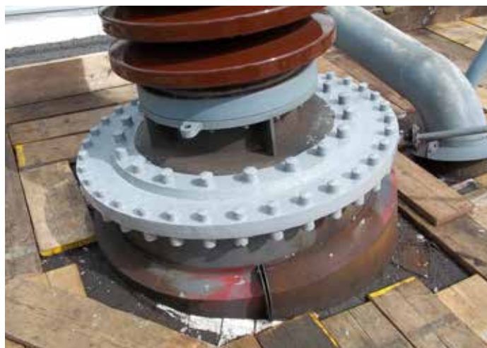
Zastosowanie materiału Belzona 5831 do eliminacji wycieku oleju z transformatora
