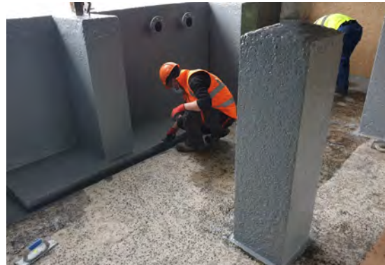
Fot.3. Nakładanie drugiej warstwy Belzona 5811
