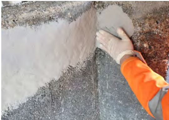
Fot.1. Przywrócenie oryginalnego kształtu Belzona 4111
