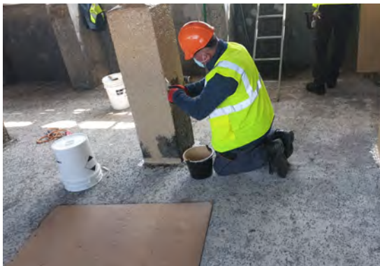
Fot.2. Nakładanie pierwszej warstwy Belzona 4151
