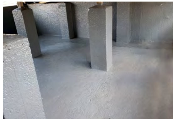
Fot.4. Gotowe zabezpieczenie konstrukcji betonowej
