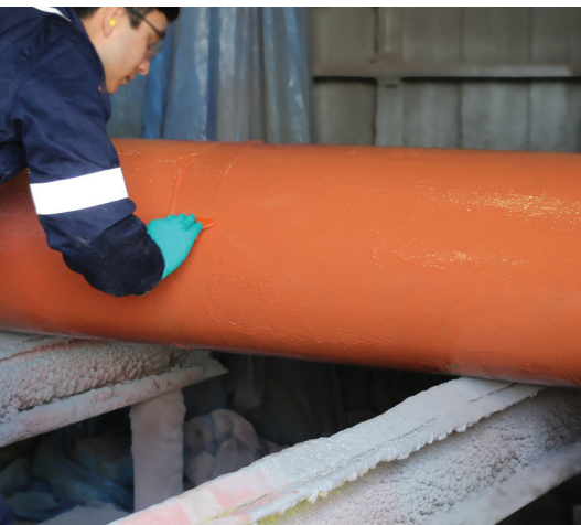
Belzona 5871® Aplikacja powłoki na płaszczy zewnętrznym podgrzewacza
