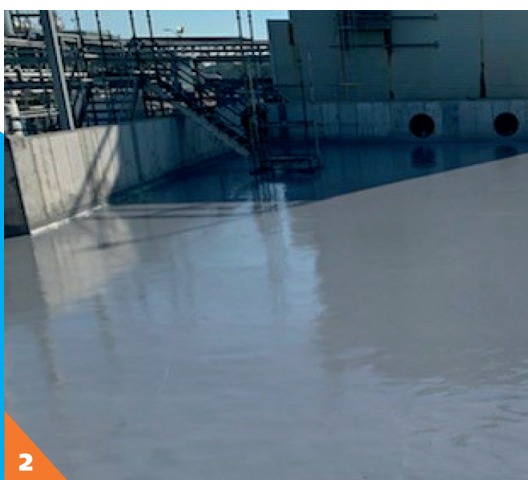
Zabezpieczenie betonowej tacy wychwytowej
