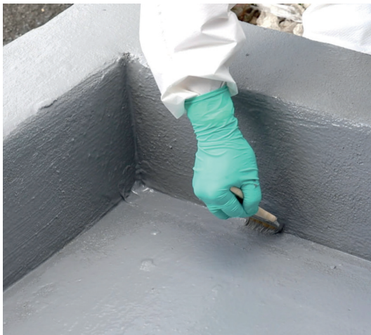
Nakładanie pędzlem Belzona 5815
