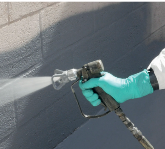
Nakładanie natryskiem Belzona 5815
