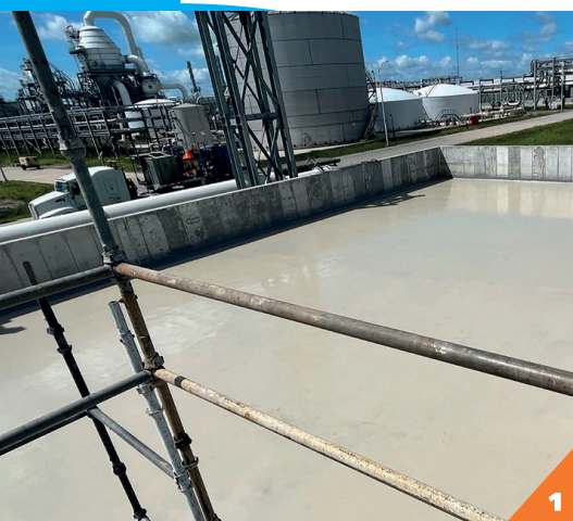
Zabezpieczenie betonowej tacy wychwytowej
