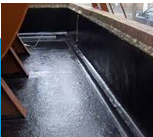
Zabezpieczenie strefy bezpiecznego przechowywania substancji chemicznych
