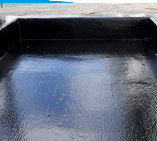
Zabezpieczenie strefy bezpiecznego przechowywania substancji chemicznych
