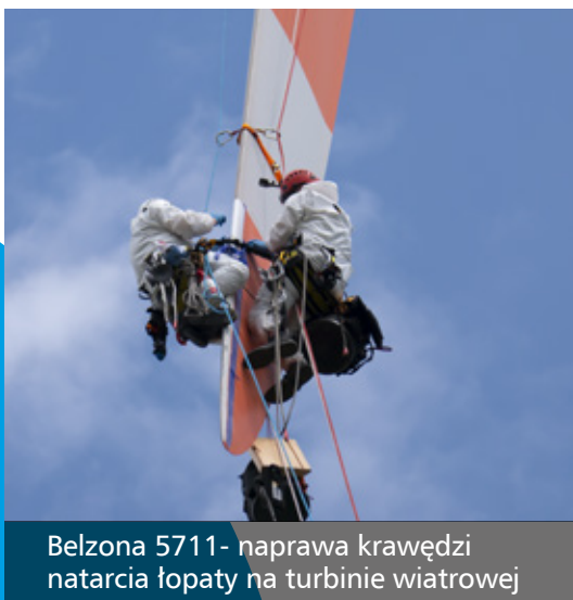
Belzona 5711- na krawędzi natarcia łopaty turbiny wiatrowej
