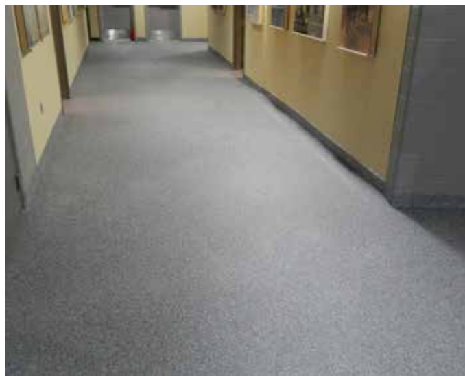
Może być stosowany jako warstwa wierzchnia na materiale Belzona 5231 z użyciem pozyskiwanych lokalnie płatków
