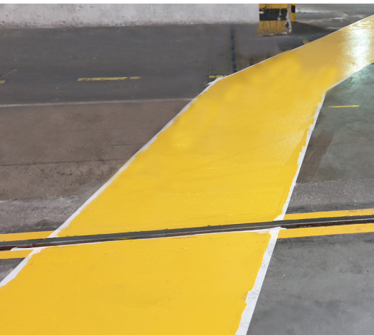
Belzona 5231 w kolorach BHP – ciągi komunikacyjne w halach przemysłowych
