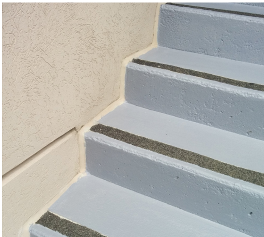
Schody odbudowane i zabezpieczone antypoślizgowo kompozytem Belzona 5231
