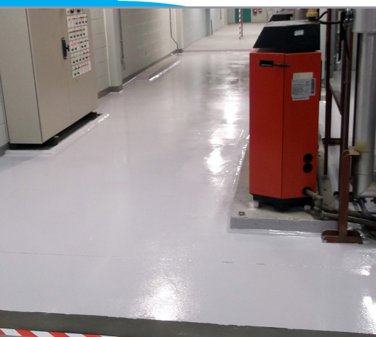
Posadzka po nałożeniu powłoki antypoślizgowej Belzona 5231
