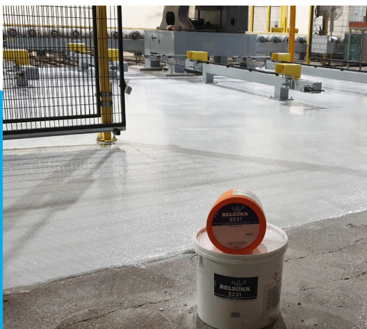
Belzona 5231 jako posadzka antypoślizgowa wokół urządzeń na hali produkcyjnej
