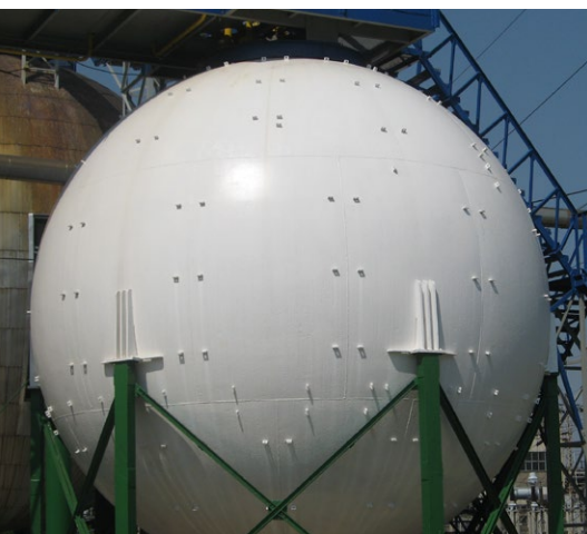
Zbiornik kulisty z powłoką Belzona® 5111 Ceramic Cladding
