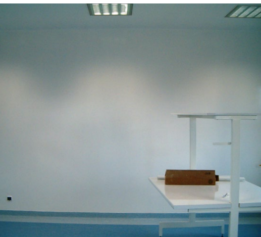
Belzona®5111 - Ściany pomieszczenia produkcji wyrobów medycznych
