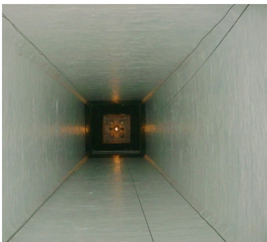
Powłoka zapobiegająca obklejaniu się ścian wieży granulacji mocznika
