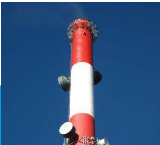
Belzona®5111 - Pasy przeszkodowe kominia
