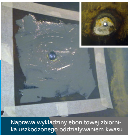
Wykładzina ebonitowa powleczone materiałem Belzona 4311
