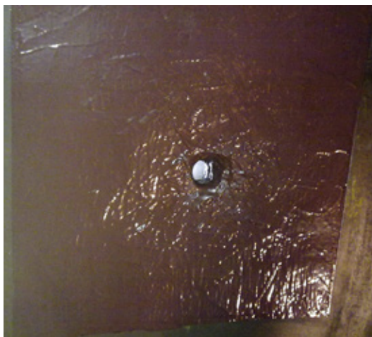
Wykładzina ebonitowa powleczone materiałem Belzona 4311
