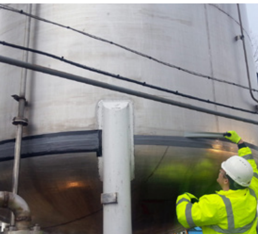
Naprawa wycieku wzdłuż podstawy zbiornika Belzona 4301
