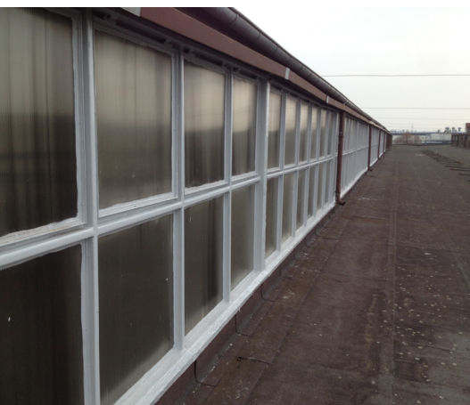
Uszczelnienie świetlików hali produkcyjnej
