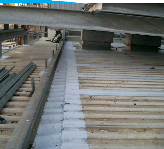
Dach elektrowni Belzona 3131
