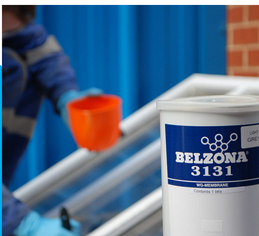
Miejscowa naprawa kompozytem Belzona 3131
