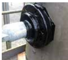
Eliminacja nieszczelności transformatora
