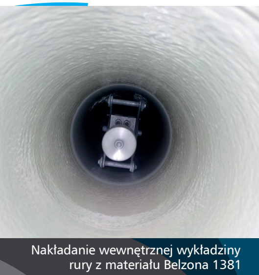
Aplikacja produktu Belzona 1381 metodą natryskową
