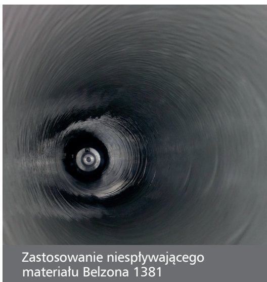
Aplikacja produktu Belzona 1381 metodą natryskową
