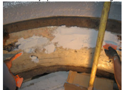
uzupełnianie ubytków kompozytem Belzona 4111
