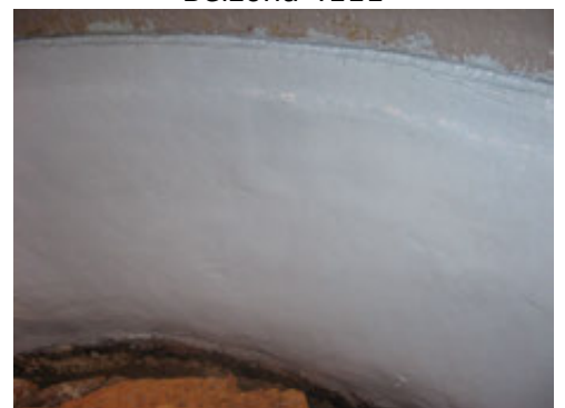
naprawiona i zabezpieczona część korpusu turbiny
