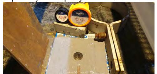
Aplikacja kompozytu Belzona 4301
