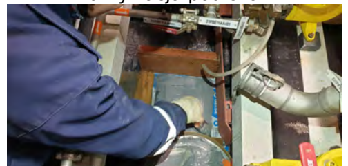
Aplikacja kompozytu Belzona 4301
